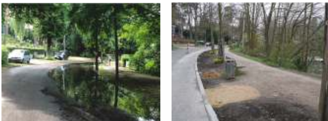
Das Foto links, das ich im vorigen Jahr von einer Groß Glienickerin erhalten hatte, zeigt die Situation der Seepromenade am südlichen Seeufer nach kräftigem Regen. Rechts: Die Fahrbahn ist ausgebaut und mit Bordsteinkanten begrenzt worden. Dahinter sind Regenmulden neu angelegt worden.
